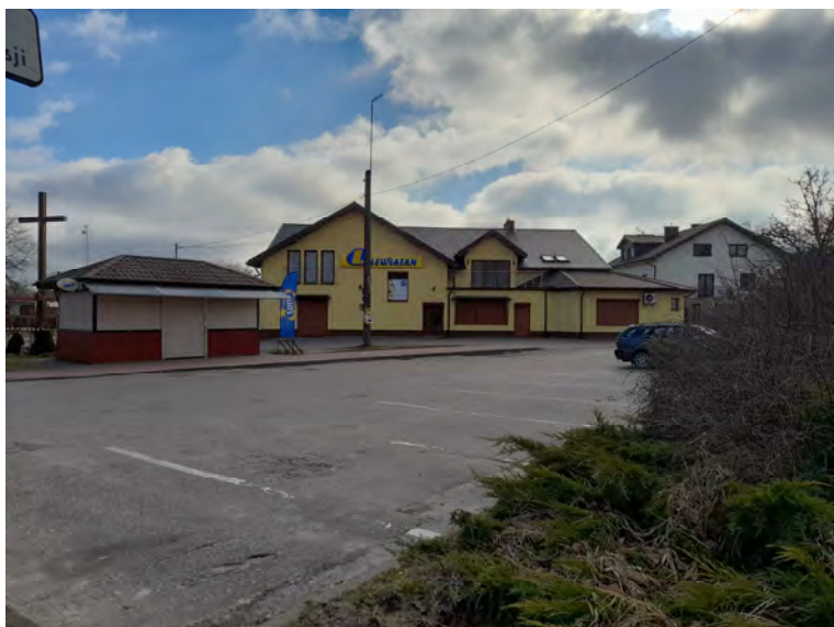
Fot. 7. Widok na teren usługowy - sklep ogólnospożywczy Lewiatan oraz totalizator sportowy Lotto.
