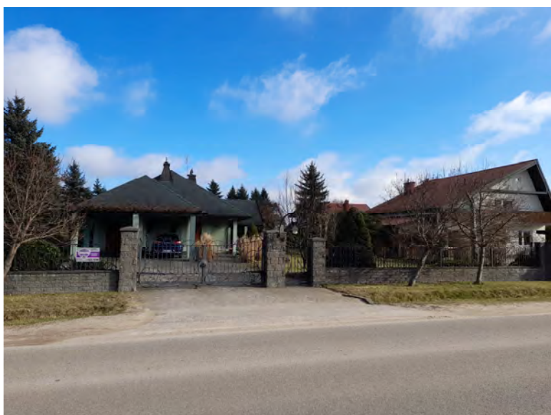
Fot. 9, 10, 11. Widok na tereny zabudowy mieszkaniowej wzdłuż ulicy Głównej.
