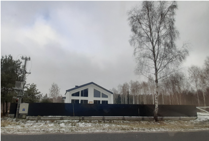
Fot. 7. Obiekt usługowy przy ul. Tarczyńskiej
