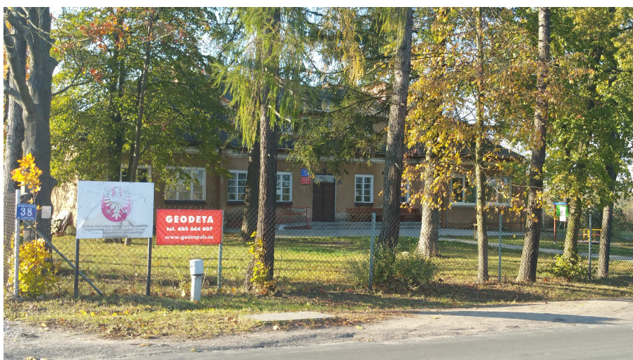
Fot.4. Budynek szkoły.
