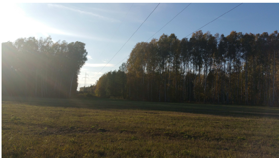
Fot.7. Linia 110kV.
