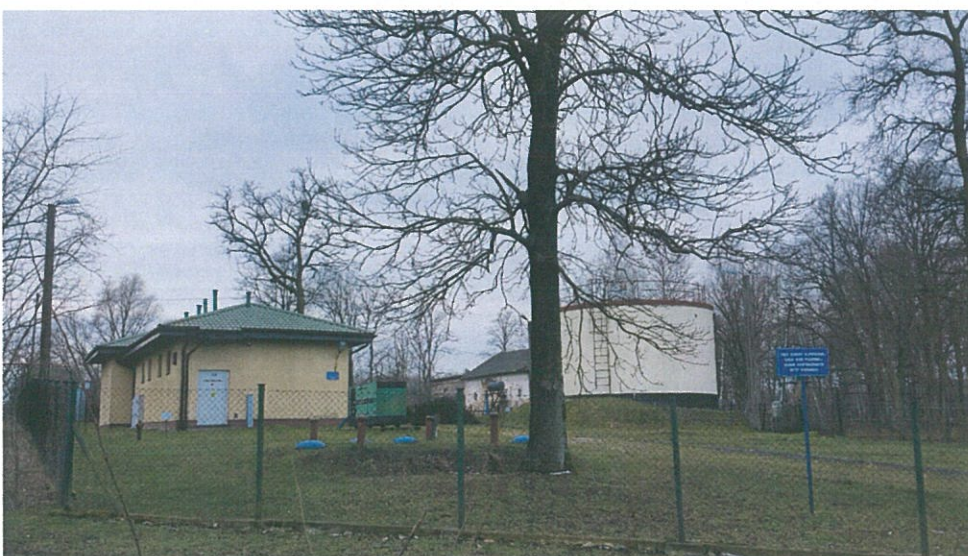
Fot.9. Ujęcie wody wraz ze stacją uzdatniania przy ul. Folwarcznej.
