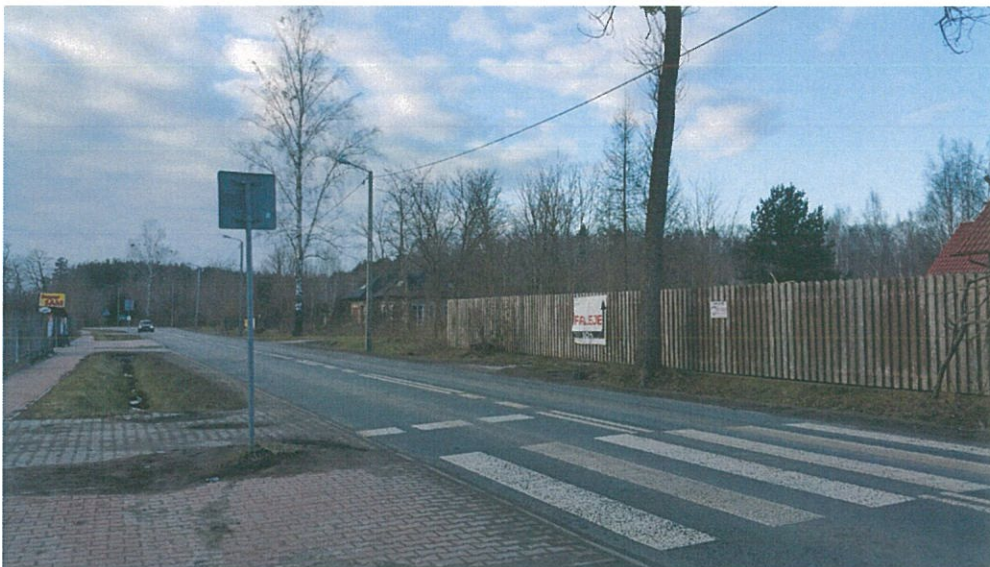
Fot.11. ul. Mazowiecka – droga powiatowa.
