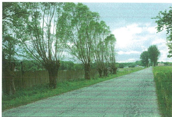
Fot. 6. Droga powiatowa nr 1521W.
