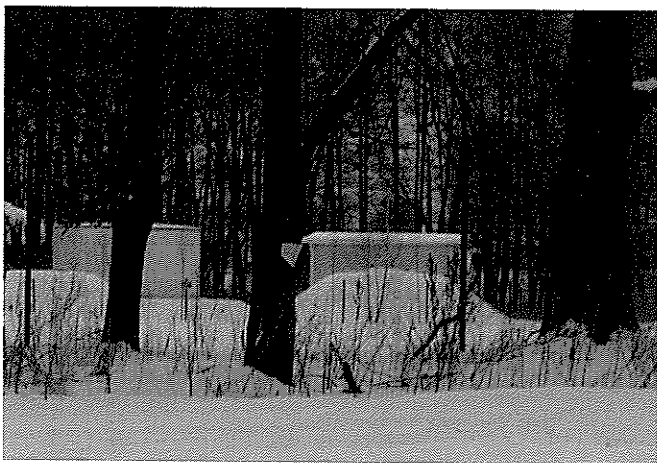
Fot. 8 . Stacja uzdatniania wody
