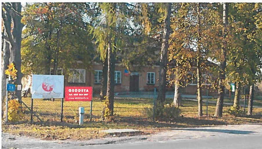
Fot.4. Budynek szkoły.
