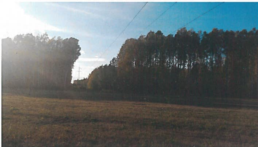
Fot.7. Linia 110kV.
