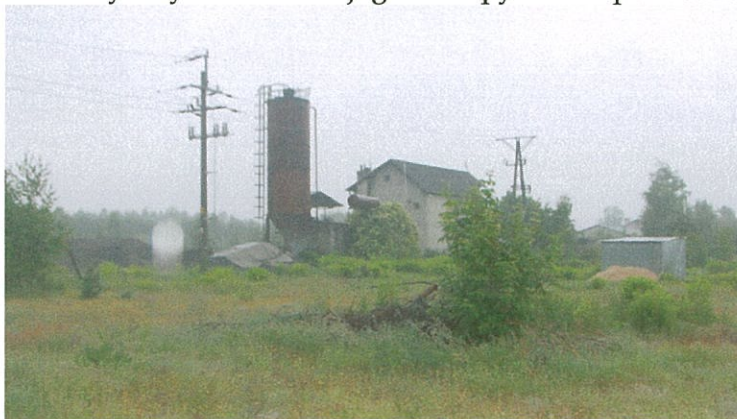
23. Betoniarnia - obiekt uciążliwy i dysharmonijny, negatywna dominanta w przestrzeni.
