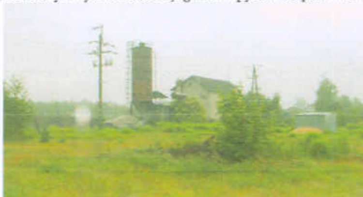
23. Betoniarnia - obiekt uciążliwy i dyszarmiczny, negatywna dominanta w przestrzeni.
