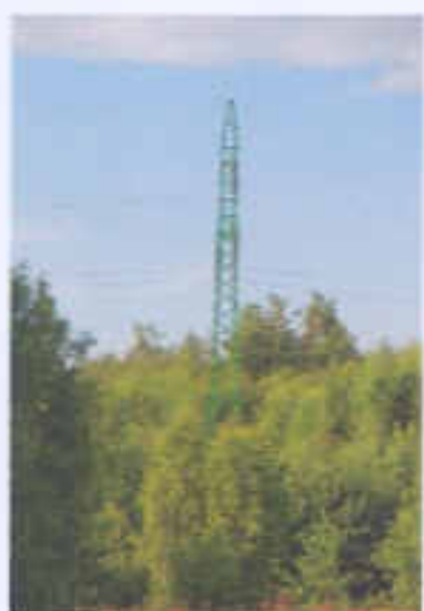
Zdj. 24. Linia elektroenergetyczna WN W południowej części Planu
